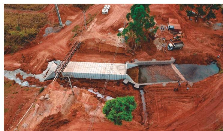
Obra da Avenida Independência inclui redes de captação, canalização, ações ambientais e reconstrução da ponte; projeto com complexidade
